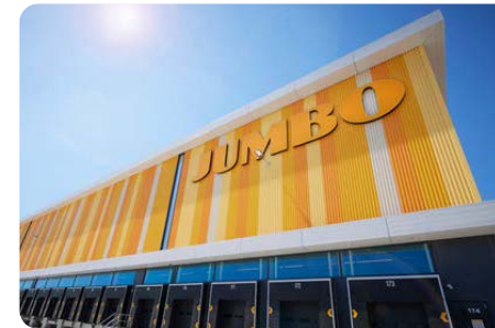
Gemechaniseerd distributiecentrum in Nieuwegein.
